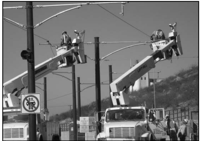
El contratista Mass Electric instalando cable
